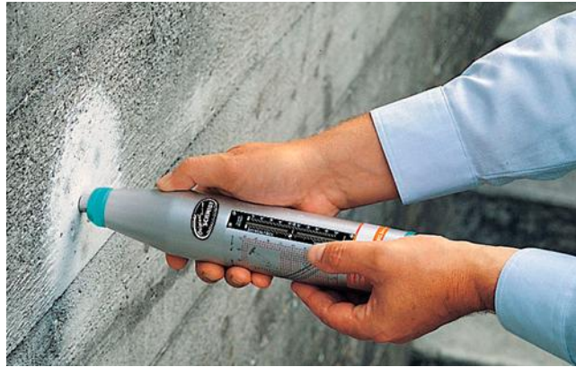
Plate 1 : The sclerometer test
