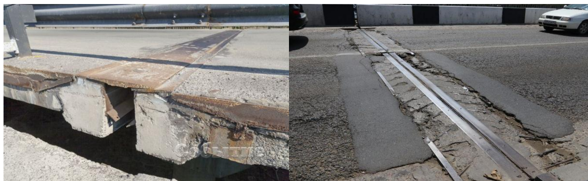
1-rasm. Deformatsiya choklarga maxsus kimyoviy moddalar ta'siri.
